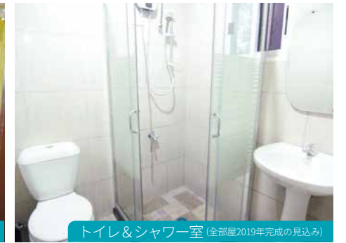
トイレ&シャワー室 (全部屋2019年完成の見込み)
